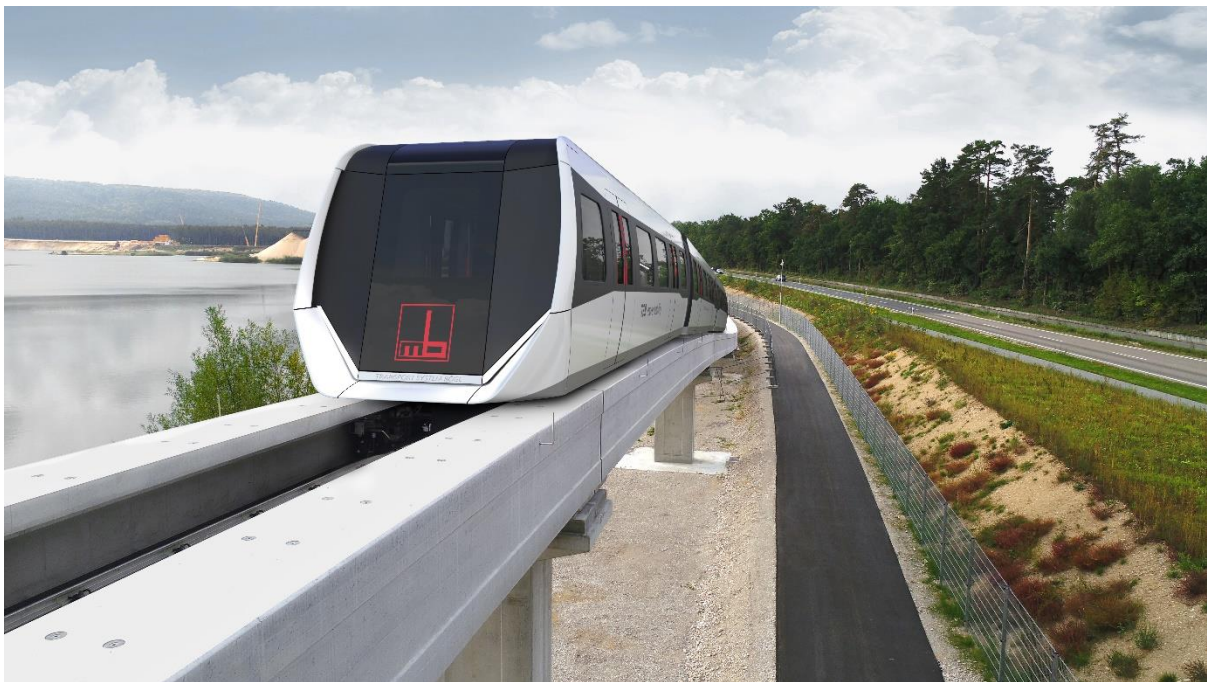
TSB auf der Teststrecke in Sengenthal, Deutschland. Bild: Firmengruppe Max Bögl
